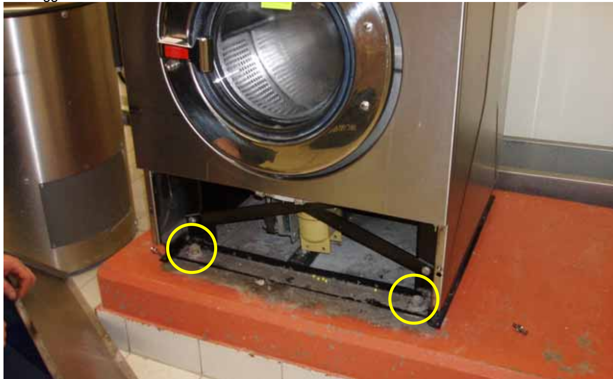
Figur 7. Tvättmaskin bultad till betongfundament.
